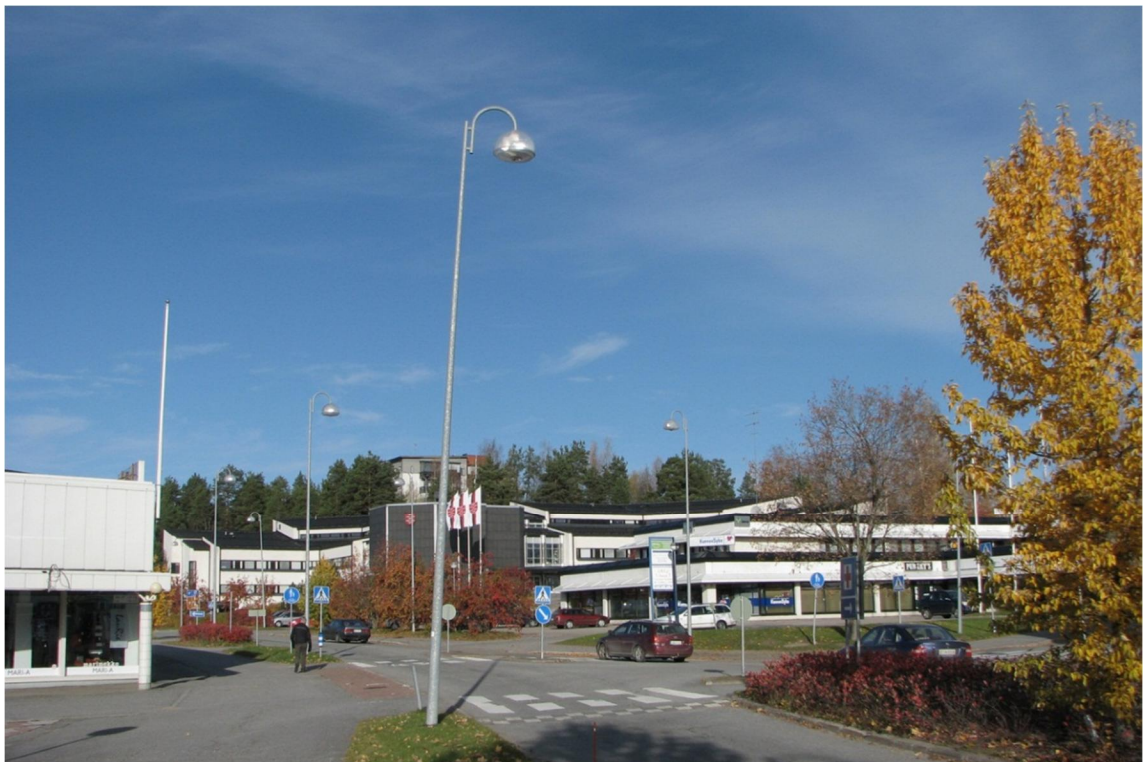
Kuva 3-10 Vuonna 1985 valmistunut linnun mallinen kunnantalarakennus, joka edustaa selkeää ja toimivaa 1980-luvun toimistorakennustyyppiä. Rakennuksen julkisivumateriaalina käytetty paikkakunnan oma kivi luo rakennukselle siteet Viitasaareen.
