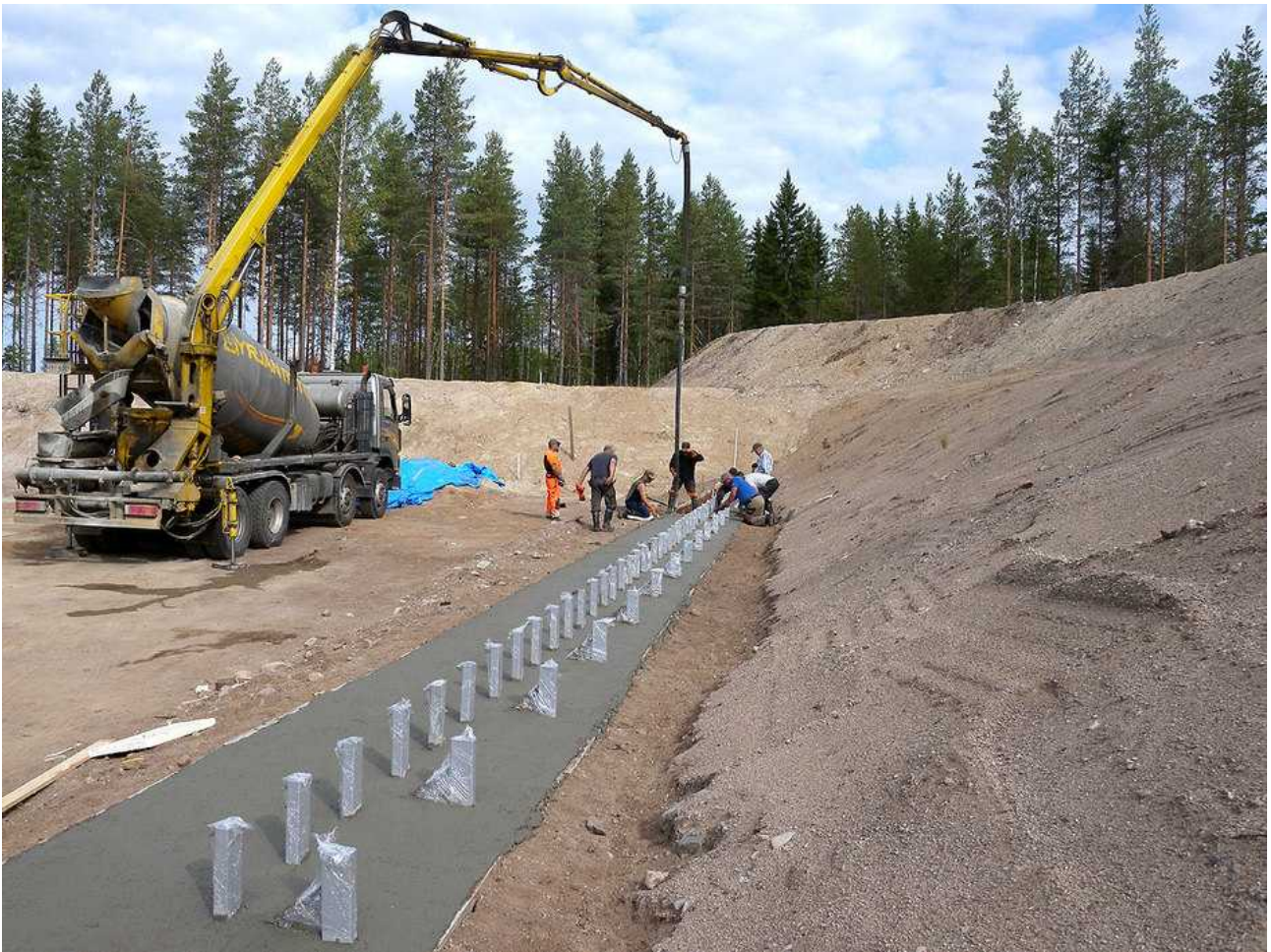
1.8.2018 Taululaitteiden kiinnikkeiden valaminen.
