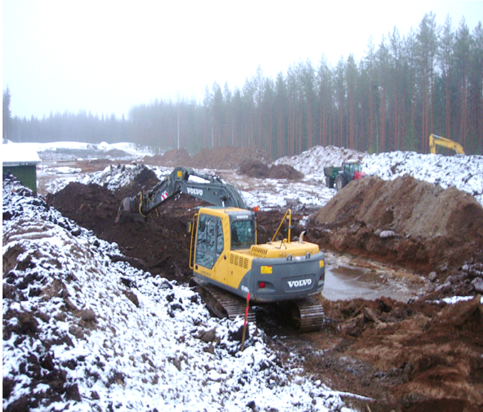
20.12.2016 Talkookaivuri- ja traktori maansiirtopuuhissa 300 m ratapohjalla.
