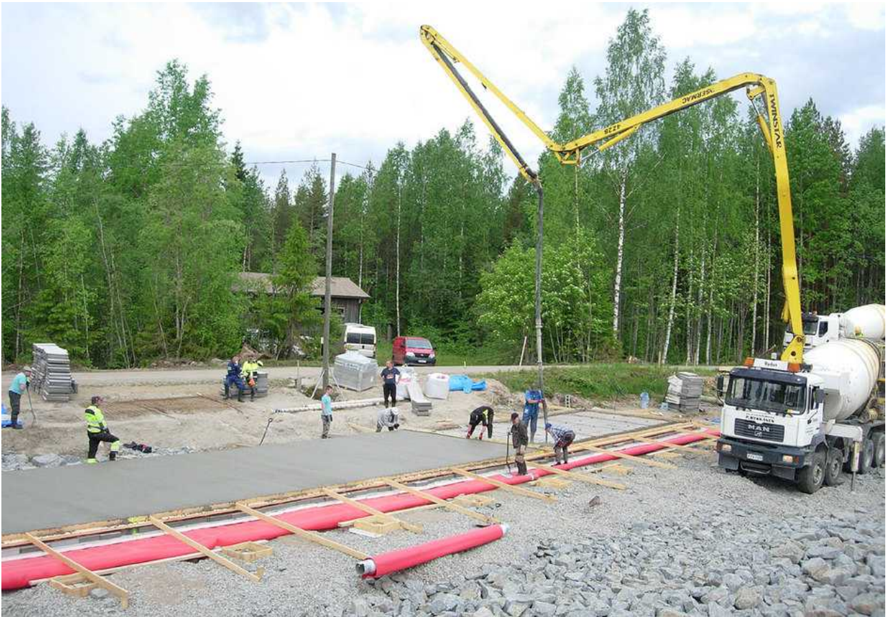
20.6.2017 Kiväärikatoksen pohjan valu.
