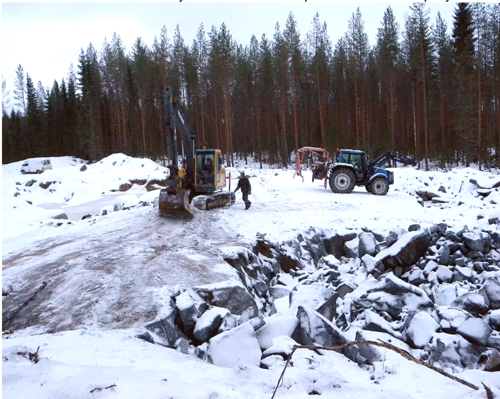
5.12.2016 Kalliokentän louhinnan valmistelua 300 m radan taulupäässä. Oikealla kolme päivää aikaisemmin räjäytetty kenttä. Yhteensä taulupäässä ammuttiin noin 2000 m 3 kalliota.
