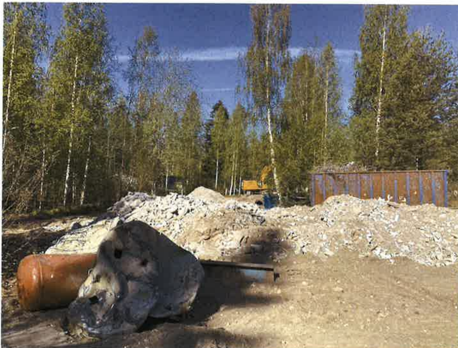
Viitasaaren Vuokra-Asunnot Oy:n purkutyömaa Joutsenkujalla. Kuva, Pirjo Nyman
