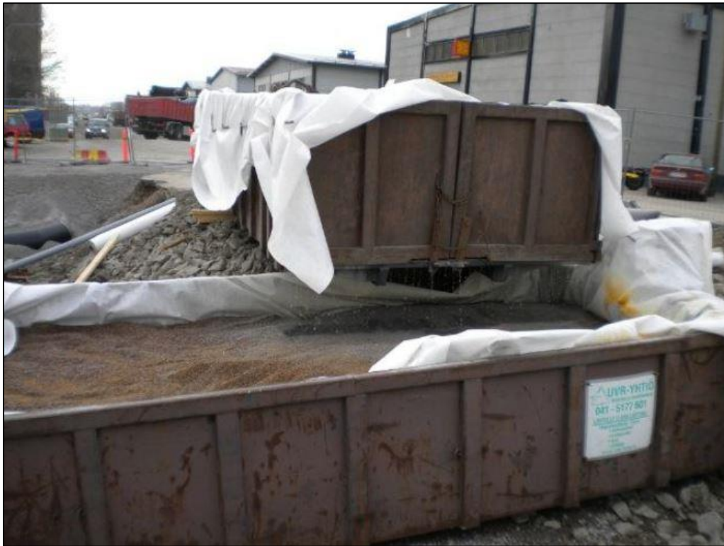
Kuva 7. Esimerkkikuva vaihtolavan sisään rakennetusta suodattimesta. 3
