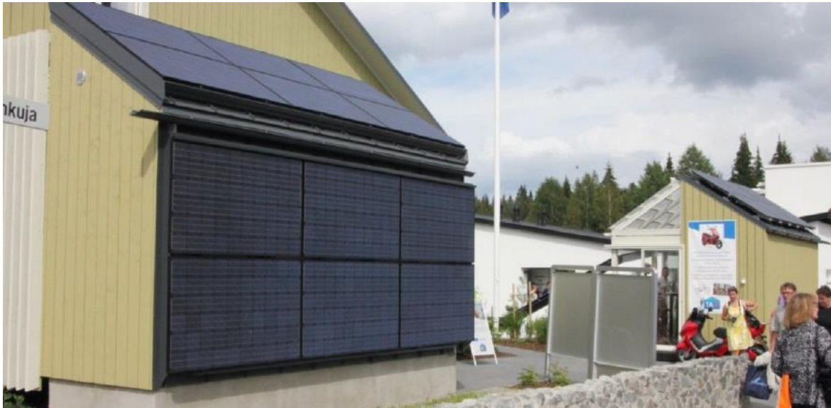
Kuva 10: Aurinkopaneeleita seinä- ja kattopinnoilla. Kuva: A. Sipponen
